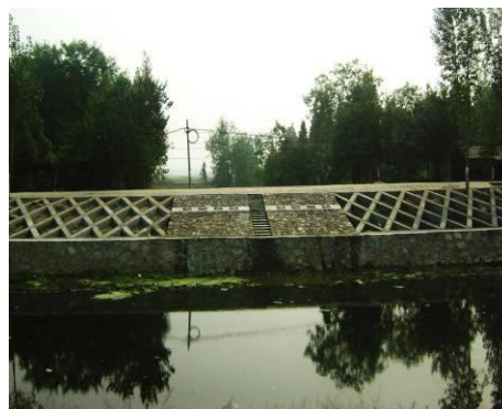
河流穿越防护及网格护坡
