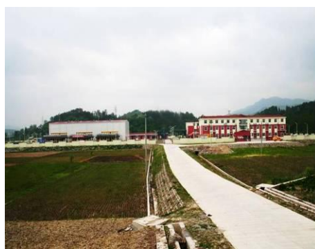
进站道路边坡防护
