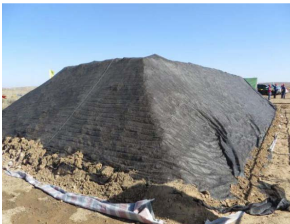
图 4-5 临时堆土苫盖措施
