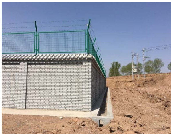
图 4-1 输气管道阀室外排水沟
