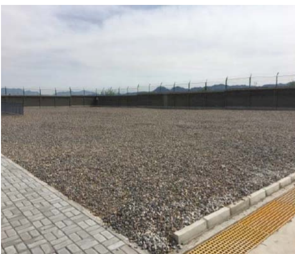
图 4-8 站场空地碎石压盖
