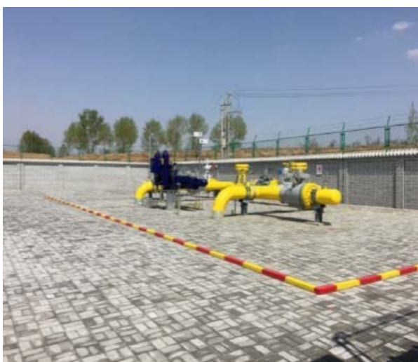
图 4-7 阀室设备区透水砖铺装
