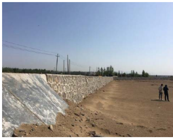
图 4-6 河流穿越护岸工程
