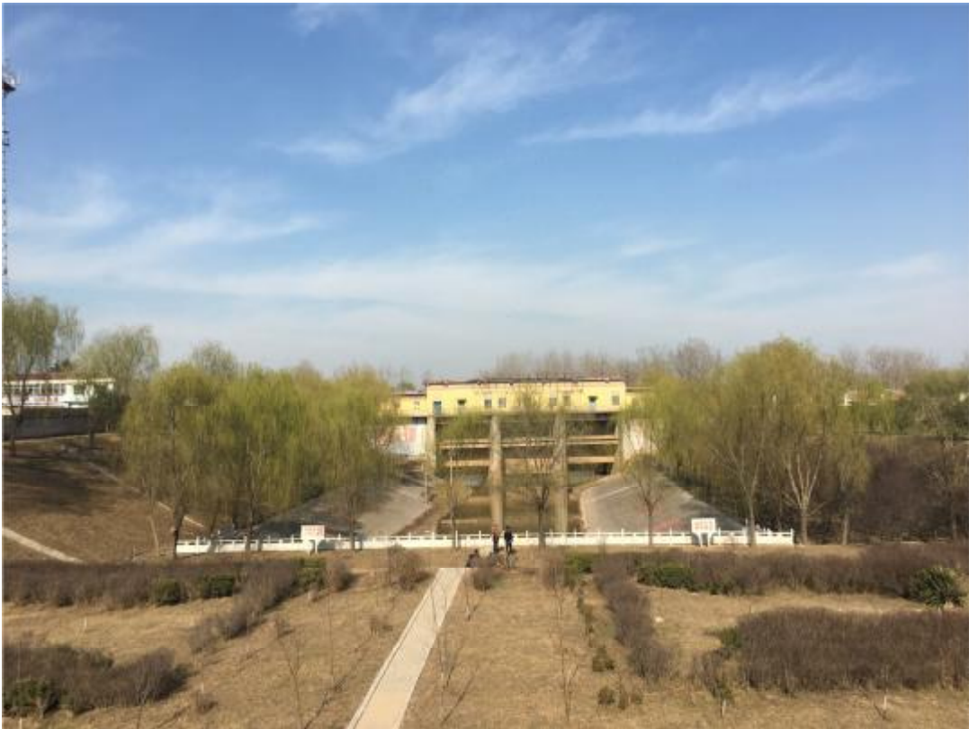
照片 1、2 红旗闸现状照片
