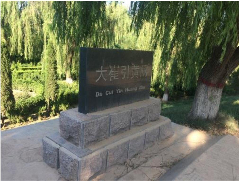
照片 7、8 大崔闸现状照片
