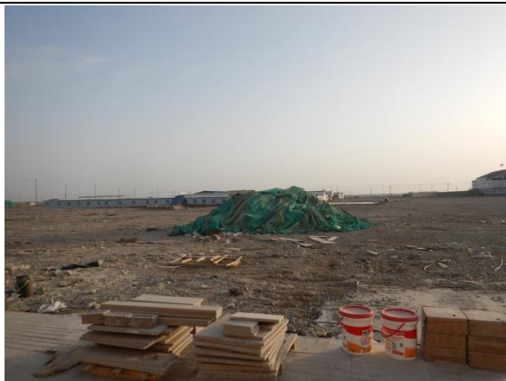
建筑材料临时苫盖
