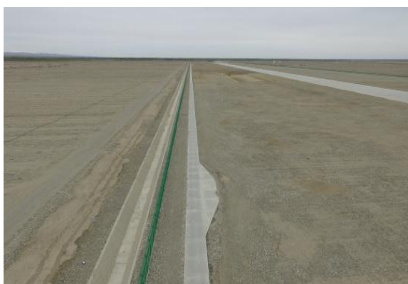
飞行区外截水沟及飞行区砂砾石压盖
