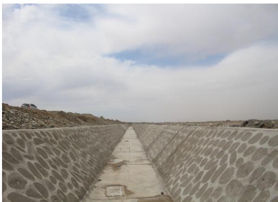
飞行区浆砌石排水沟
