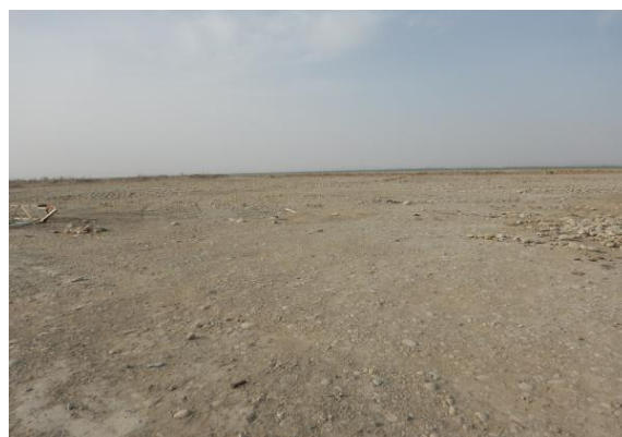
施工生产生活区(二)
