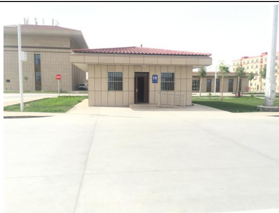
建筑物和道路之间空地绿化（二）
