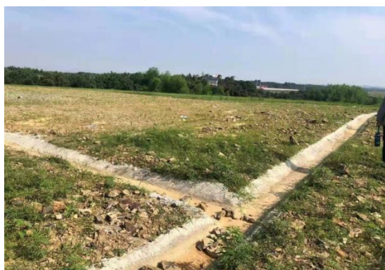
图2.3-11 Z2渣场渣面排水沟
