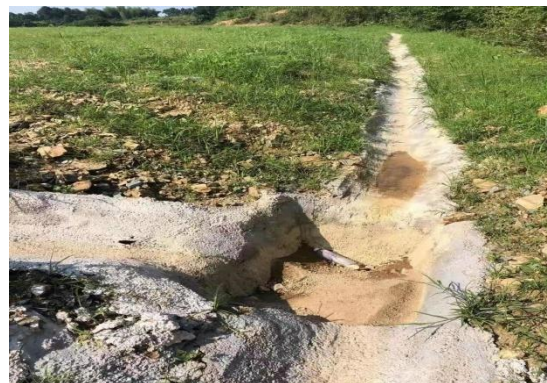
图2.3-5 Z1渣场渣面排水沟
