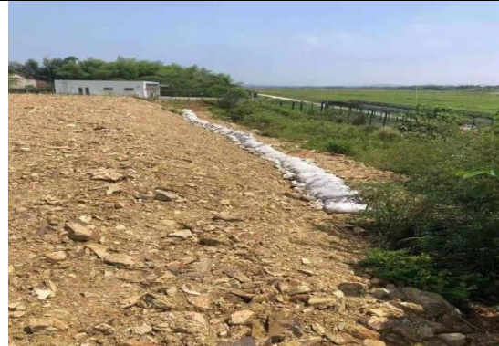
图2.3-19 Z3渣场东侧边坡袋装土拦挡(整治时)
