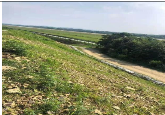
图2.3-13 Z2渣场东侧边坡袋装土拦挡
