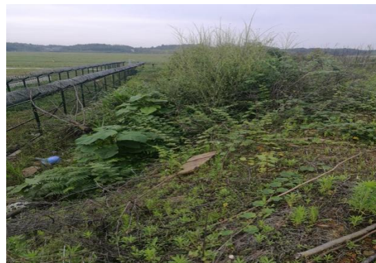
图2.3-17 Z3渣场临机场围界边坡
