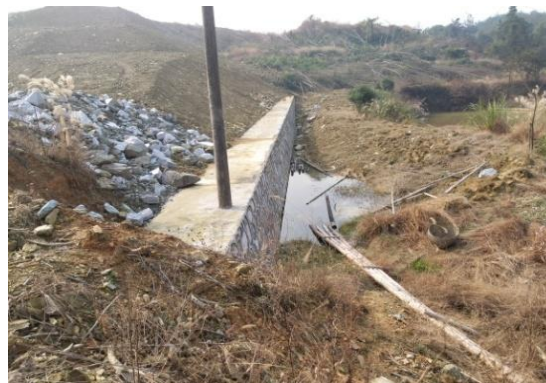
图2.3-10 Z2渣场浆砌石挡渣墙
