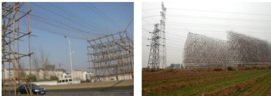
图2.2-2 线路工程临时跨越形式典型照片
