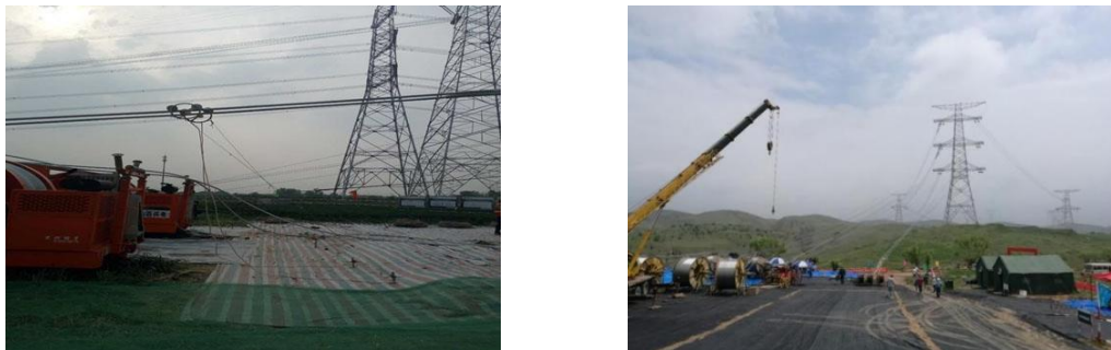
图2.2-1 线路工程沿线牵张场布置形式典型照片
