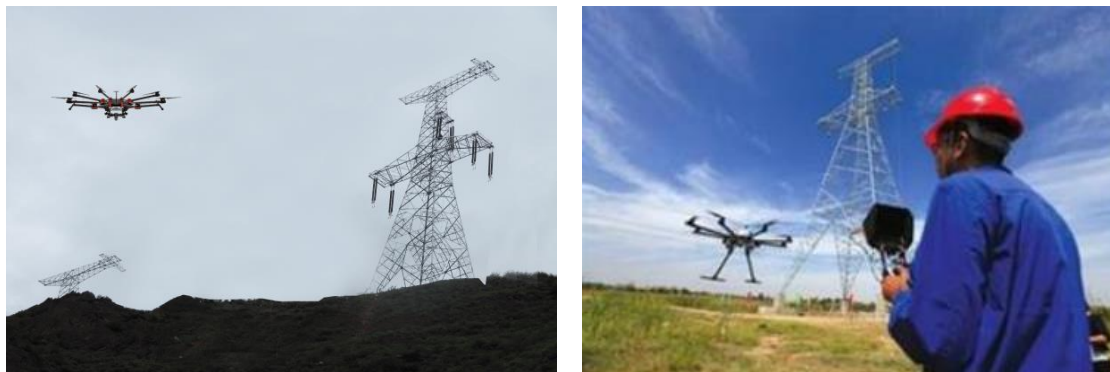
图 2.2-5 无人机展放导引绳施工典型照片
