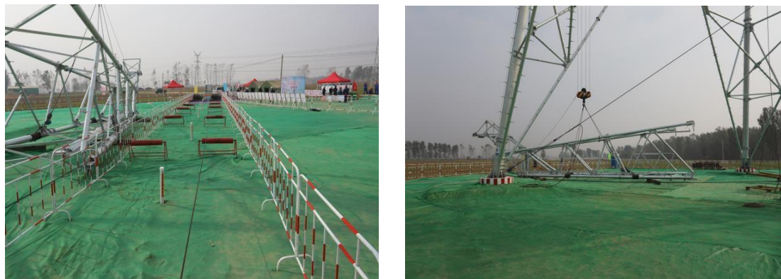
图 2.2-4 类似线路工程铁塔组装典型照片
